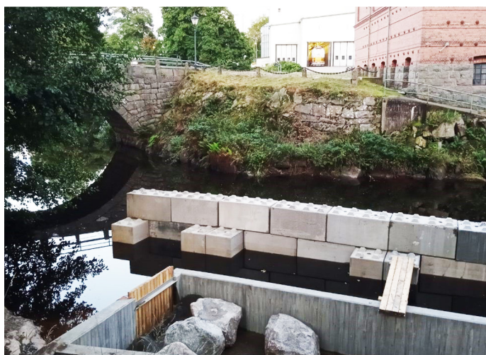
Bild ö: Legoblocken läggs på plats av dykare och kran Bild n: Intag till nya fiskvägen
