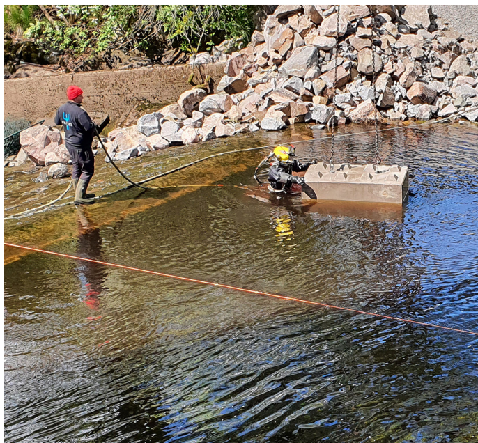
Bild ö: Legoblocken läggs på plats av dykare och kran Bild n: Intag till nya fiskvägen
